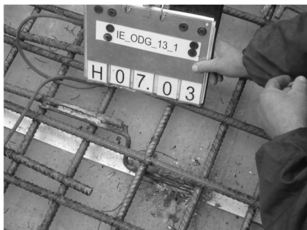
Rys. 5. Połączenie spawane pośrednie (z prętym Z) płaskownika uziomu z prętym zbrojeniowym
