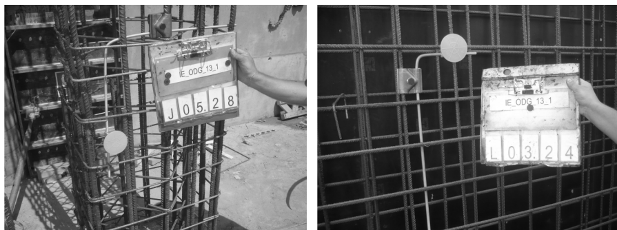
Rys. 7. Sposób mocowania i przyłączenia za pomocą zacisku Maxi MV St wypustu uziemiającego typu K firmy DEHN
