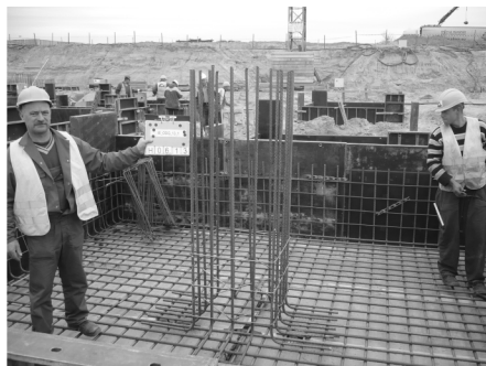
Rys. 4. Sposób łączenia płaskowników uziomu z wybranymi prętami zbrojeniowymi, stanowiącymi naturalne przewody uziemiające przechodzące przez poszczególne kondygnacje
