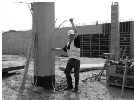
Rys. 3. Wyrowadzenie przewodów kraty wyrównania potencjału w posadzce betonowej poziomu piwnic
