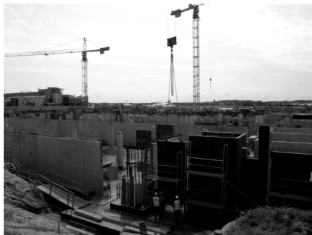
Rys. 1. Ogólny widok placu budowy w sierpniu 2010
