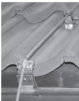
Rys. 2. Poprawne użycie zacisku dwumetalowego Al-Cu
