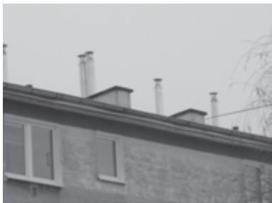
Rys. 1. Wywiewniki i wyloty kanałów dymowych zakończone niewidocznymi na fotografii prętami zwiększającymi wysokość konstrukcji do 1,4 m
