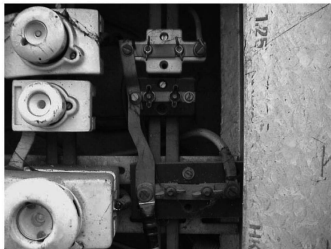
Bild 1: Verteiler mit Neutralleiterklemme mit Flügelmuttern
